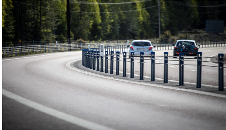
Figure 7 : Barrière en câble métallique sur une route 2+1
