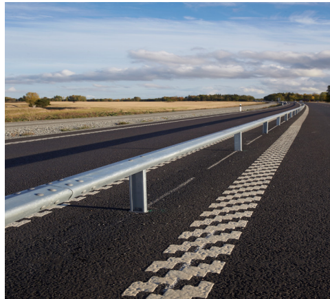
Figure 8 : Barrière en acier semi-rigide sur une route suédoise 2+1
