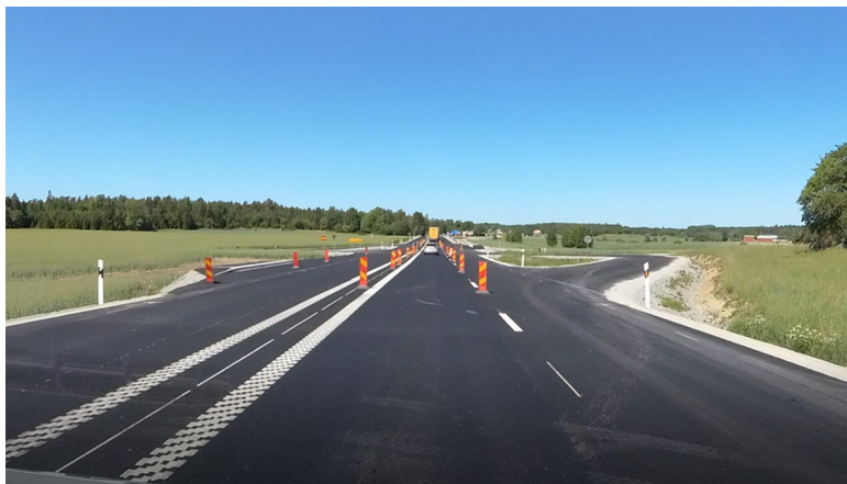
Figure 14 : Chantier de construction d'une route 2+1 en Suède
