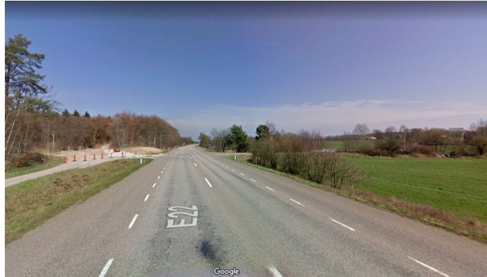
Figure 3 : Autoroute suédoise rurale avant la conversion 2+1
